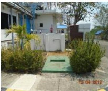
Ilustración 4 Tanque de almacenamiento y tanque elevado
