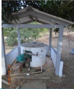
Fotografía 18 Pozo de agua profundo Fuente: E.T.S.A S.A.S, 2019
