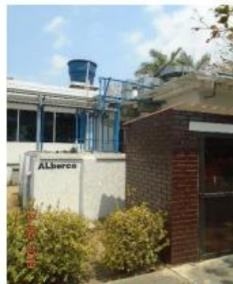
Fotografía 20 Tanque elevado de agua potable Fuente: E.T.S.A S.A.S, 2019
